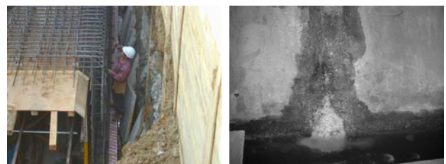
개착식 구조물 시공현황
