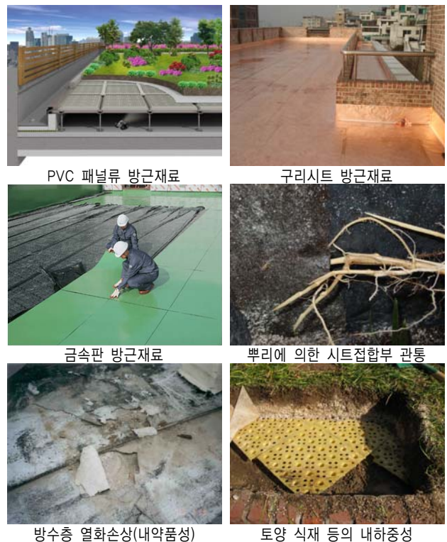
사진 7. 방근재료의 종류 및 하자사례
